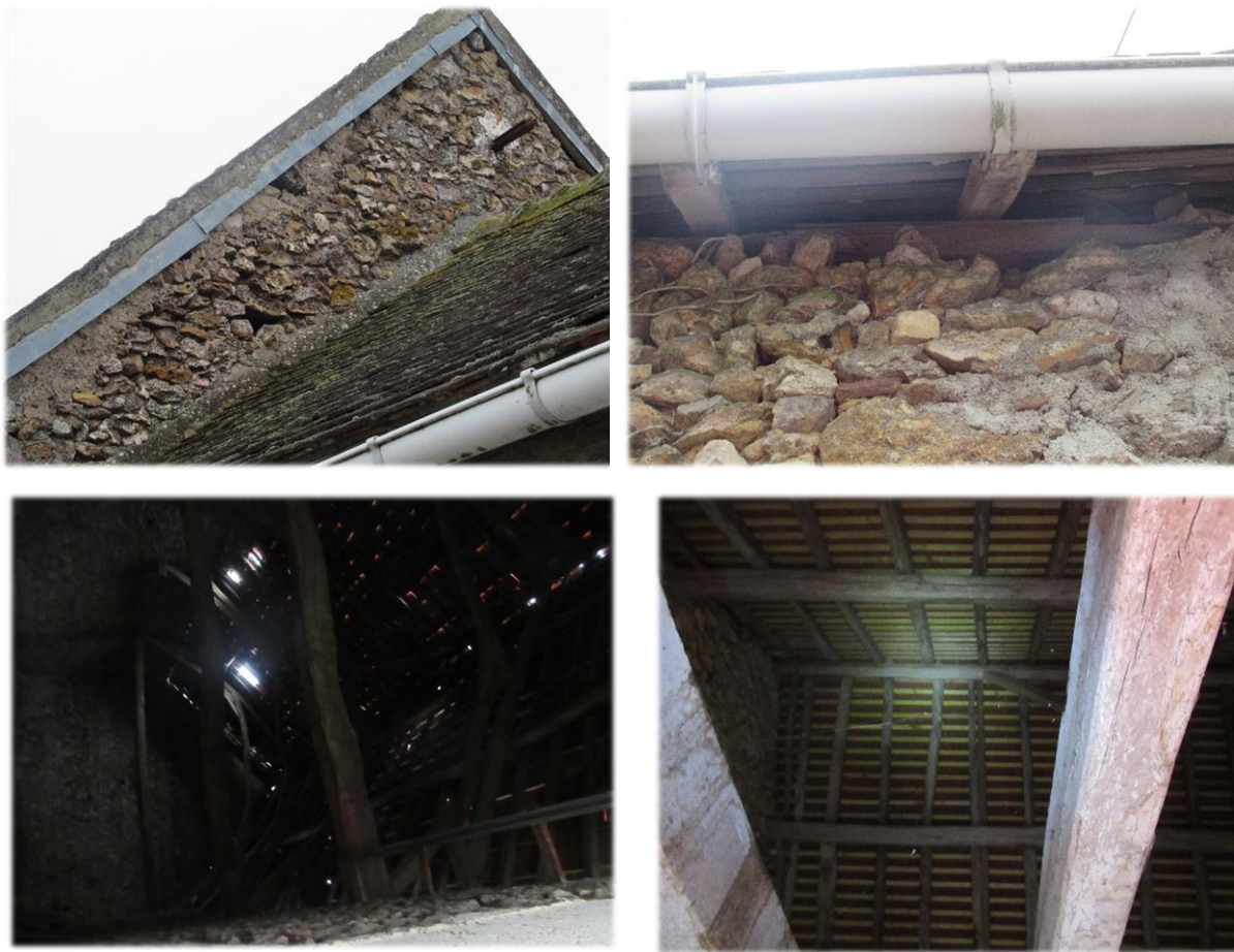
Exemple de bâti favorables au gîte des chiroptères
