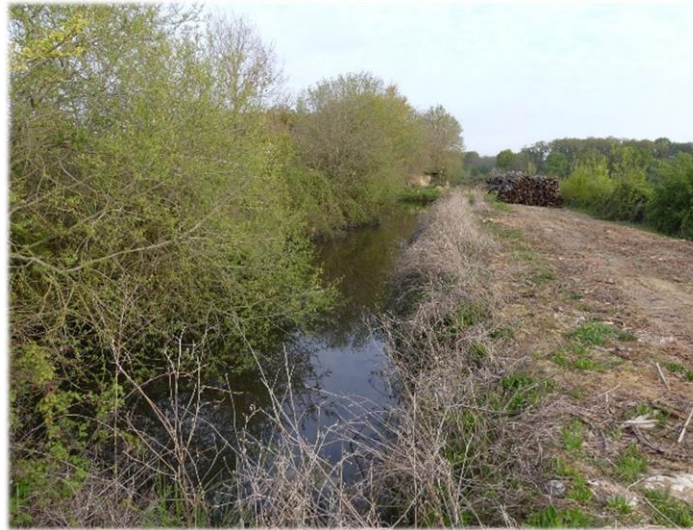
Bassin de rétention
